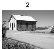
Broken Hill.jpg 240 KB
