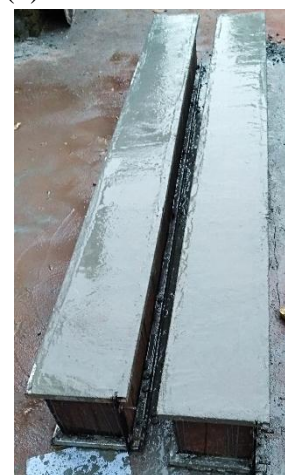
(d) Concrete finishing
